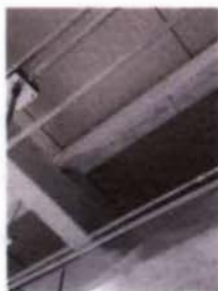
DEFICIENCIA EN LA APLICACIÓN DE LA PINTURA ANTI FUEGO "SYLPRIL"
