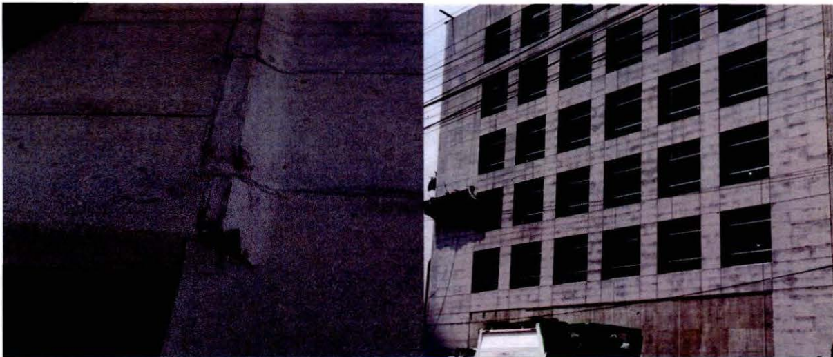
Impermeabilización con detalles de calidad
