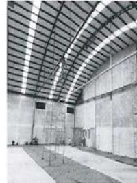
d. Se construyó una tridilosa entre el área de almacén y el edificio administrativo, de la que no se cuenta con el cálculo estructural ni la licencia para su realización. Dicho elemento presenta “parches” que permiten filtraciones. La tridilosa no se consideró en el proyecto entregado por la SCJN.
