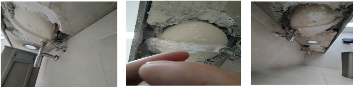
**g.** La fabricación de escalones y descanso con concreto hecho en obra con revolvedora  $f'c=200\text{kg/cm}^2$ , resistencia normal rev. 12cm, presentan fisuras.
