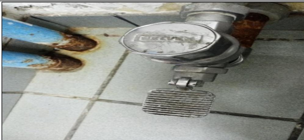
Se advirtió oxidación en la tubería que conecta la base del fluxómetro.
