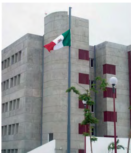
Edificio Sede del Poder Judicial de la Federación en el Vigésimo Primer Circuito, en Acapulco, Guerrero
