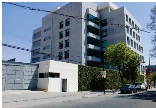
EDIFICIO CHIMALPOPOCA (EDIF. DE OFICINAS)
