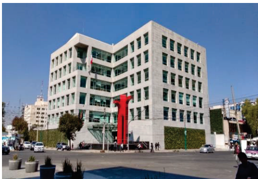
EDIFICIO CHIMALPOPOCA (EDIF. DE OFICINAS)
