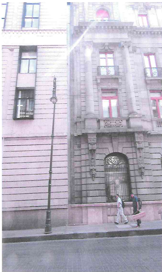
Vista de la junta de colindancia norte. La separación es del orden de 10 cm constante en toda su altura.
