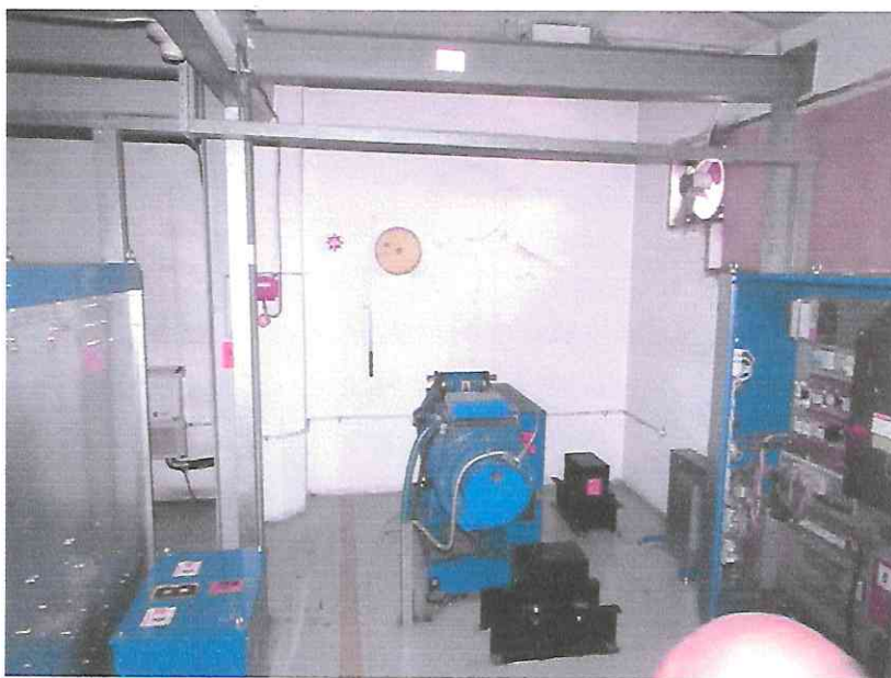
Se observó la adición de columnas y trabes de acero como refuerzo a la estructura de marcos de concreto.
