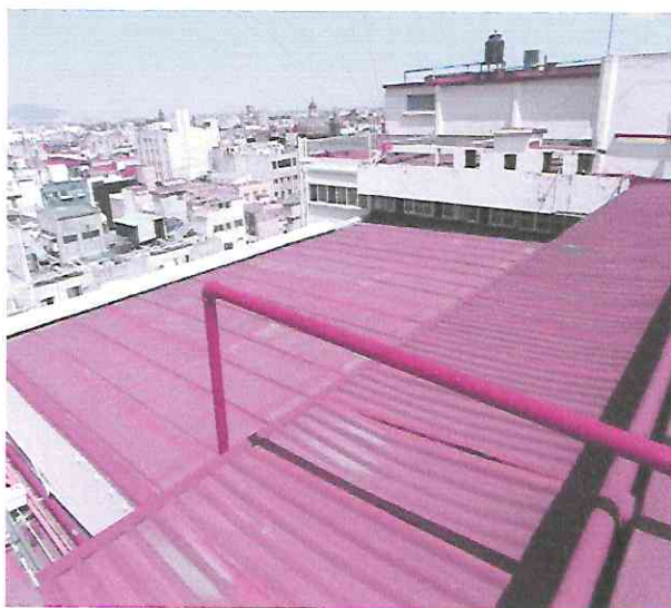
Vista de travesaños que soportaba la cisterna que ya fue demolida. Atrás se observan los cuartos de servicio y de máquinas de los elevadores.
