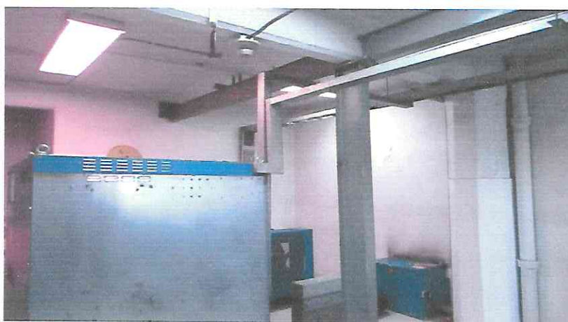
Columna de acero como refuerzo en el cuarto de máquinas del elevador.
