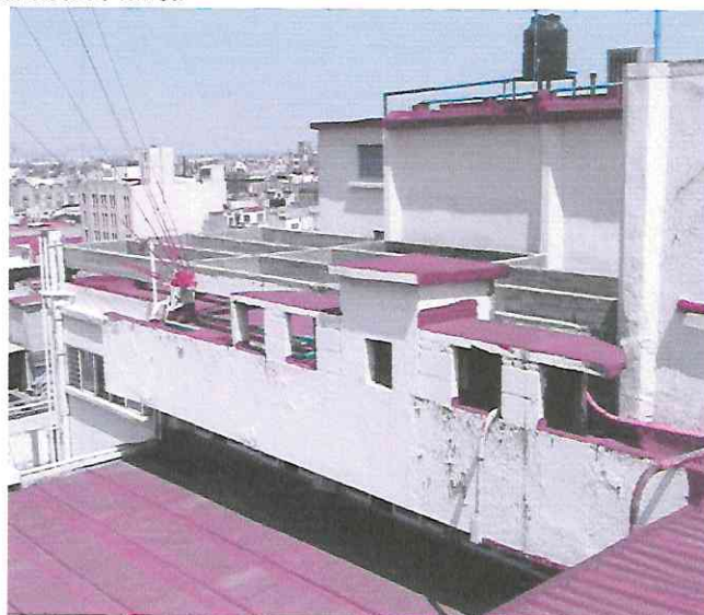
Vista de travesaños que soportaba la cisterna que ya fue demolida. Atrás se observan los cuartos de servicio y de máquinas de los elevadores.
