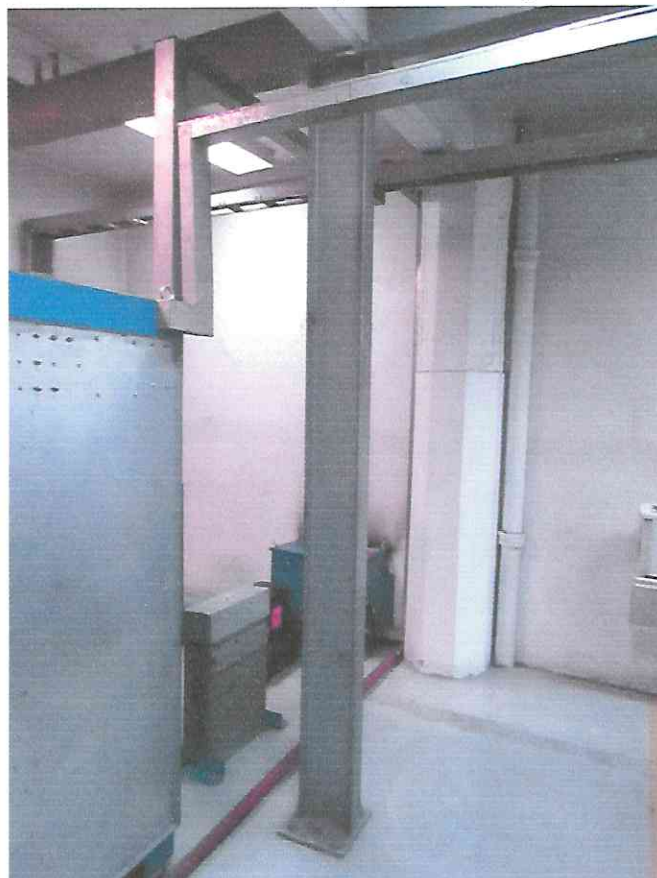
Columna de acero como refuerzo en el cuarto de máquinas del elevador.
