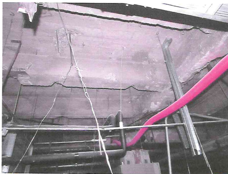
Primer nivel. Las losas cuentan con trabes secundarias de acero distribuidas en forma equidistante.
