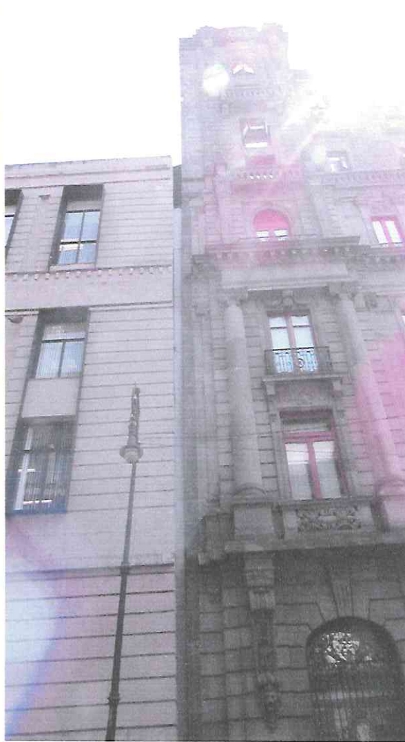
Vista de la junta de colindancia norte. La separación es del orden de 10 cm constante en toda su altura.
