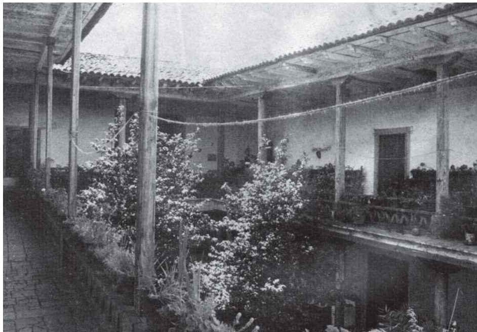
En este edificio de la Villa de Ario fue instalado, el 7 de marzo de 1815, el Supremo Tribunal de Justicia de la América Mexicana. Su primer presidente fue don José María Sánchez de Arriola.
