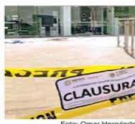
Los jóvenes murieron tras caer desde un tercer piso debido al rompimiento de un barandil de cristal en el que estaban recargados, dentro de un bar. / 11 Foto: Omar Hernández
