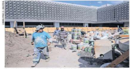
Por quinta ocasión se realizan trabajos de impermeabilización y cambio de piso en la explanada, debido a filtraciones.
