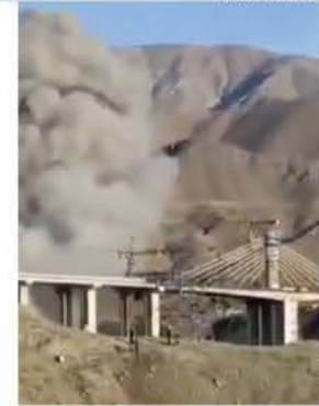
DERRUMBE del puente más alto de Irán.
