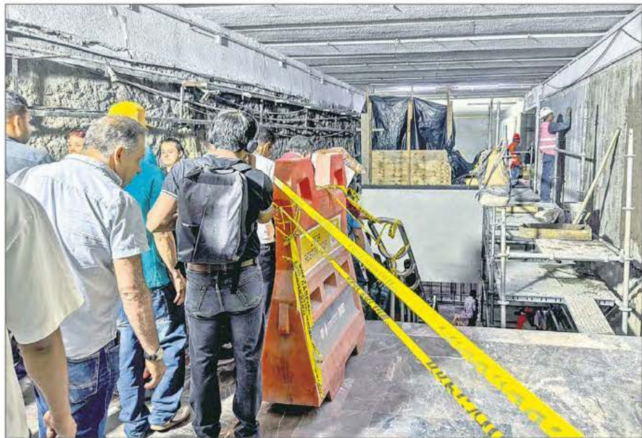
▲ A 47 días del Mundial, trabajadores apresuran el remozamiento de las estaciones de la línea que va de Tasqueña a Cuatro Caminos. Los usuarios caminan entre materiales, escombros, polvo y ruido, en pasillos y andenes reducidos y a veces semioscuros. En tanto, 11
