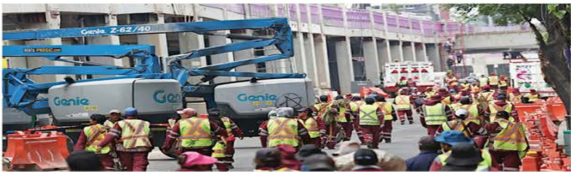
Aspecto de las obras en Chabacano y San Antonio en dirección el Centro Histórico.
