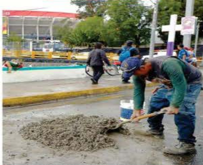
A marchas forzadas y entre la lluvia, continúan las obras fuera del Estadio mundialista en la CDMX.
