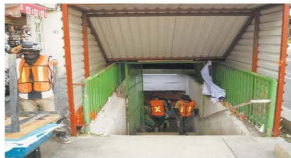
En el paso a desnivel de San Antonio Abad y Gutiérrez Nájera continúan las obras.
