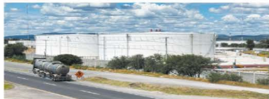
Enormes depósitos de combustibles se alzan junto a las viviendas, lo que ocasiona temor.
