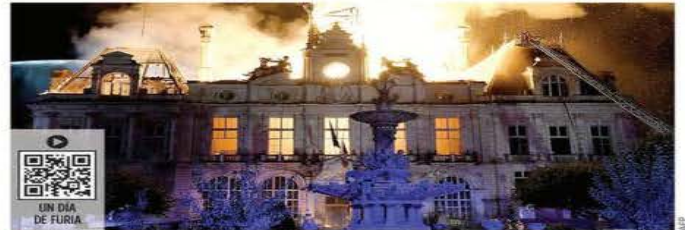
Manifestantes prendieron fuego al edificio del Ayuntamiento en Limoges, que data de 1876.
