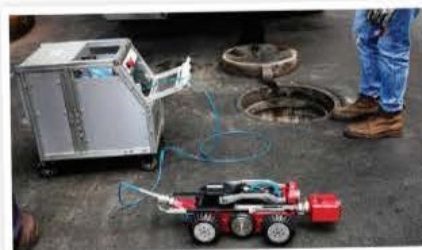
UN VEHÍCULO con cámara recorre la tubería del pozo contaminado.
